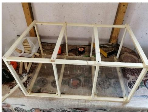
Рисунок 15 – Установка дна из поликарбоната
