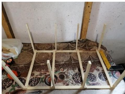
Рисунок 13 – Установка поперечных стоек
