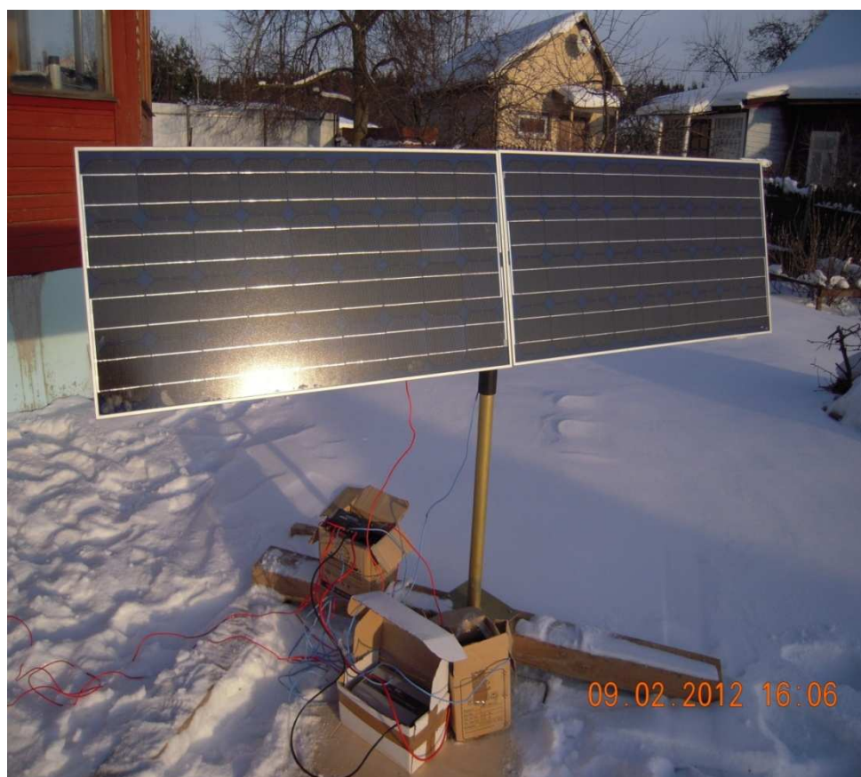
Рис. 1 Солнечная электростанция на базе блока из двух кремниевых панелей на территории участка сельского дома
